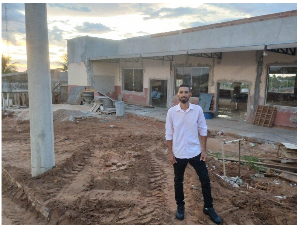
Foto 2 – Registro do início das obras de reforma do Clube “PLIMEC”.
