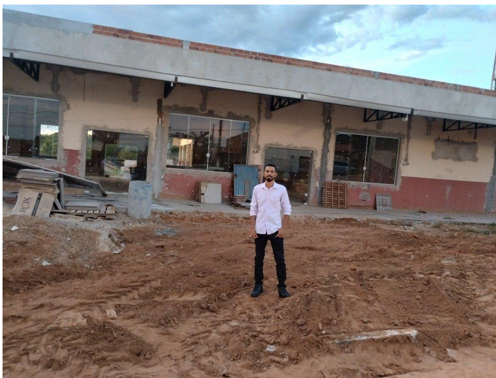
Foto 1 – Registro do início das obras de reforma do Clube “PLIMEC”.
